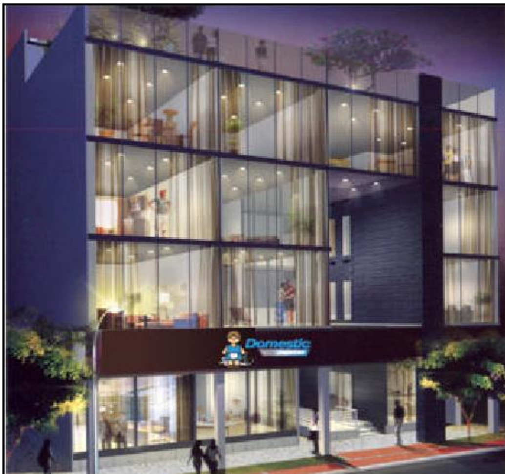
Vista Externa de la Oficina
