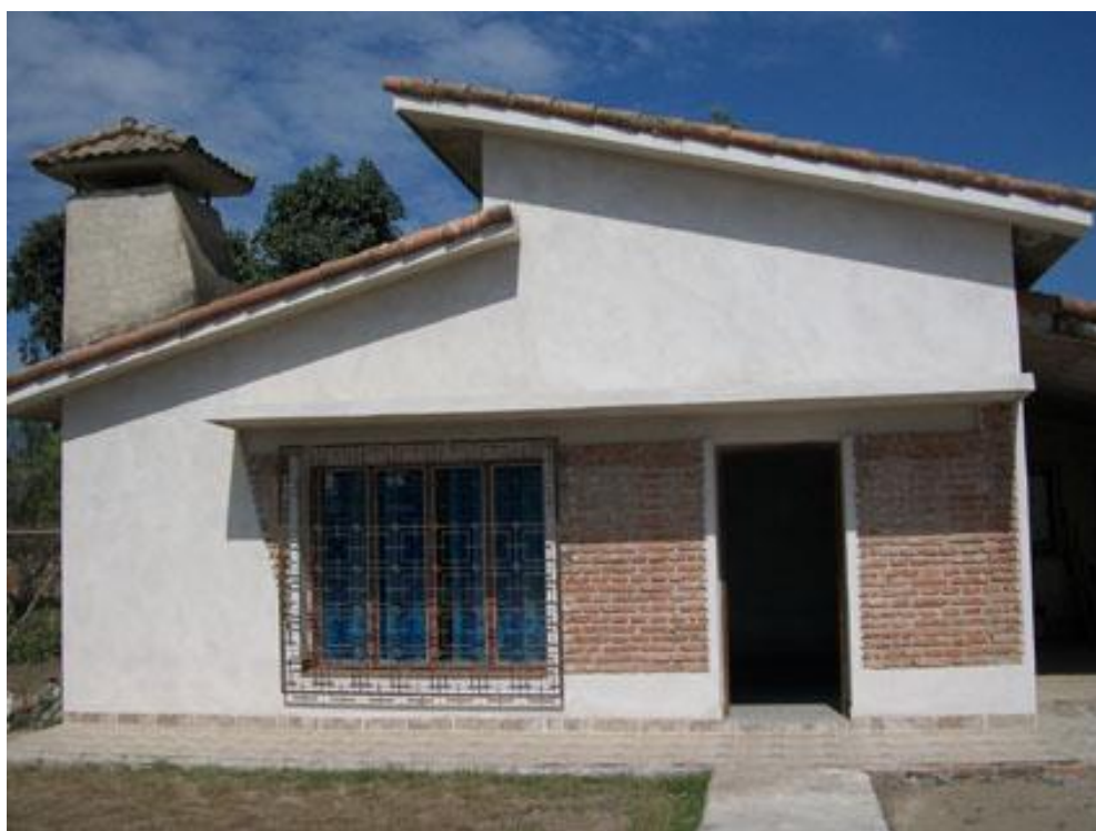
Instalaciones Laboratorio Coop. PROCAIN Ltda.
