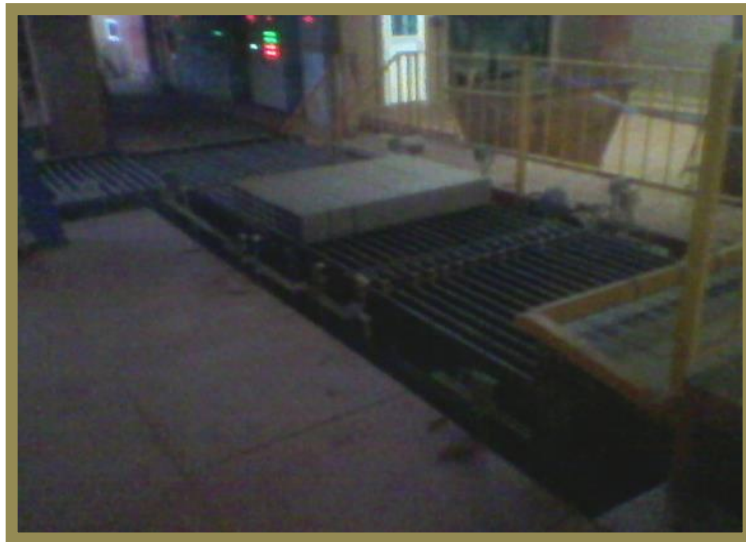
Imagen de maquinaria utilizada para el corte de los ladrillos:
