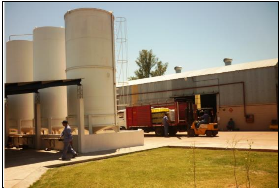
Cisternas propias ubicadas en el depósito de El Cevilar.
