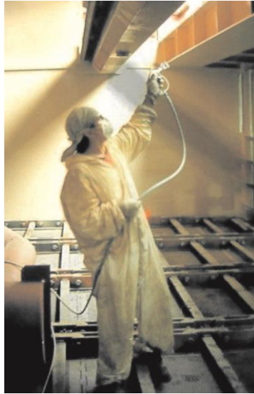
Figura N° 2. Operario aplicando pintura epoxi.
