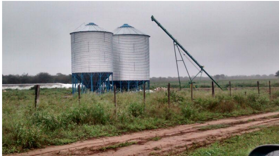
Figura 31. Silos y chimango.
