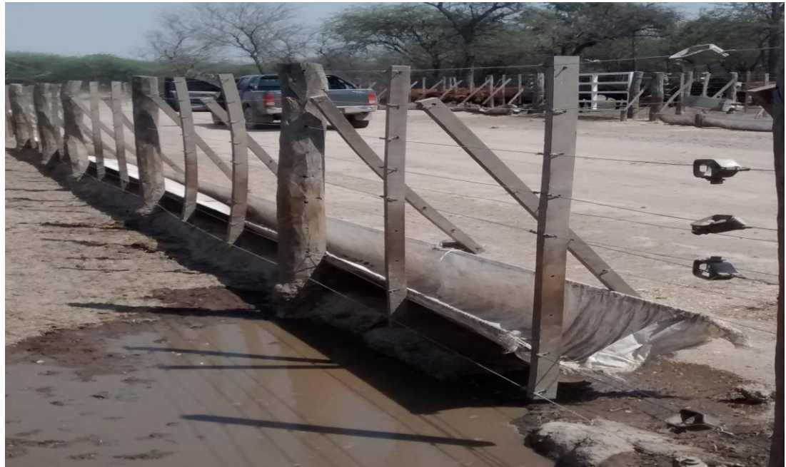
Figura 22. Vista de adentro del corral.
