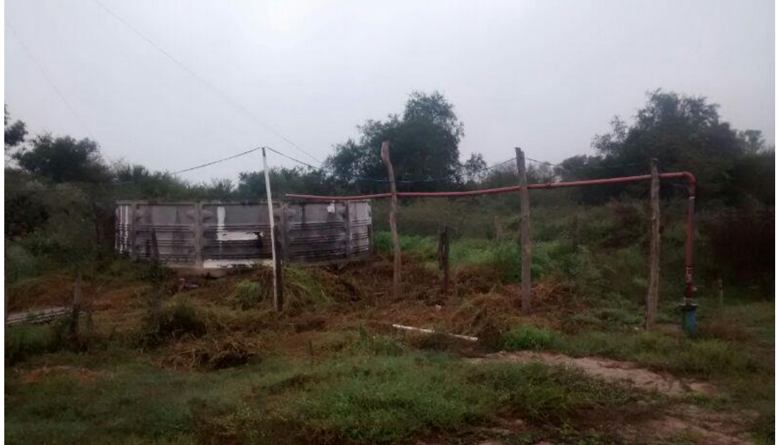
Figura 21. Tanque australiano alimentado con pozo de agua (se extrae con una bomba sumergible de 4 pulgadas de 3 hp)
