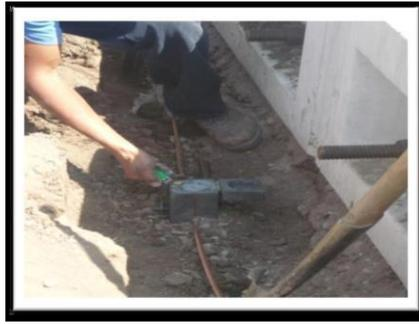
Imagen 14: Soldadura cuproaluminotérmica
