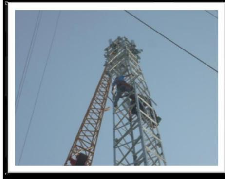
Imagen 12: Ensamble tercer tramo
