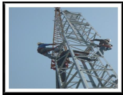
Imagen 9: Ensamble primer y segundo tramo
